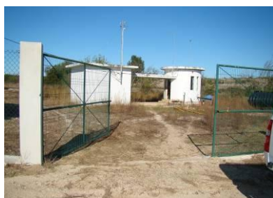
Fig. 4a. Poço S. Gens1: aspecto exterior da caseta de protecção
