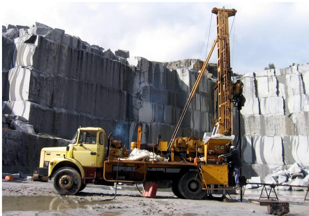
Fig. 28. Decurso dos trabalhos de perfuração da sondagem SMA 1
