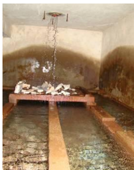
Fig. 11b. Interior da construção de alvenaria.
