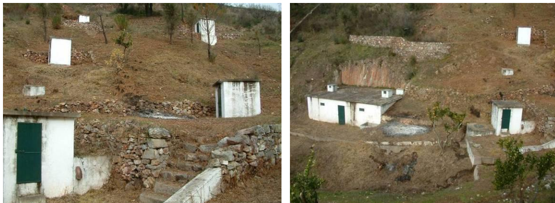
Fig. 8a e 8b. Conjunto de galerias construídas em 1944 para captar a água dos quartzitos
