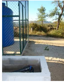
Fig. 2b. Caseta do furo
