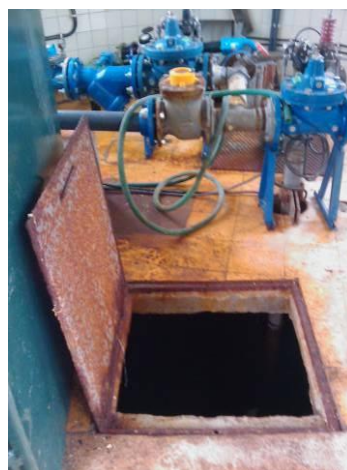
Fig. 4b. Aspecto do interior da construção de alvenaria na qual se localiza o poço
