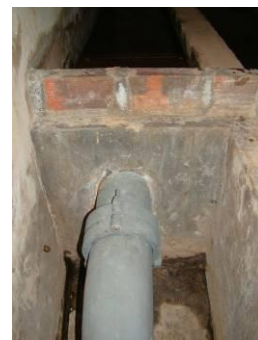
Fig. 11c. Canalização da água para o reservatório.
