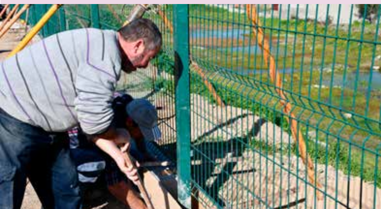
NISA - Reconstrução de Vedação no Campo de Jogos
