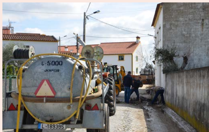
AREZ Limpeza e desentupimento de sumidouros
