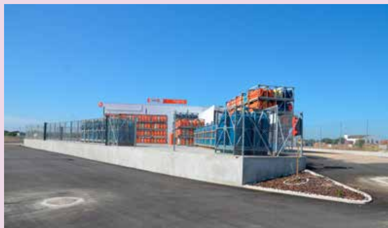
Novas instalações da empresa Nisagáz na ZAE
