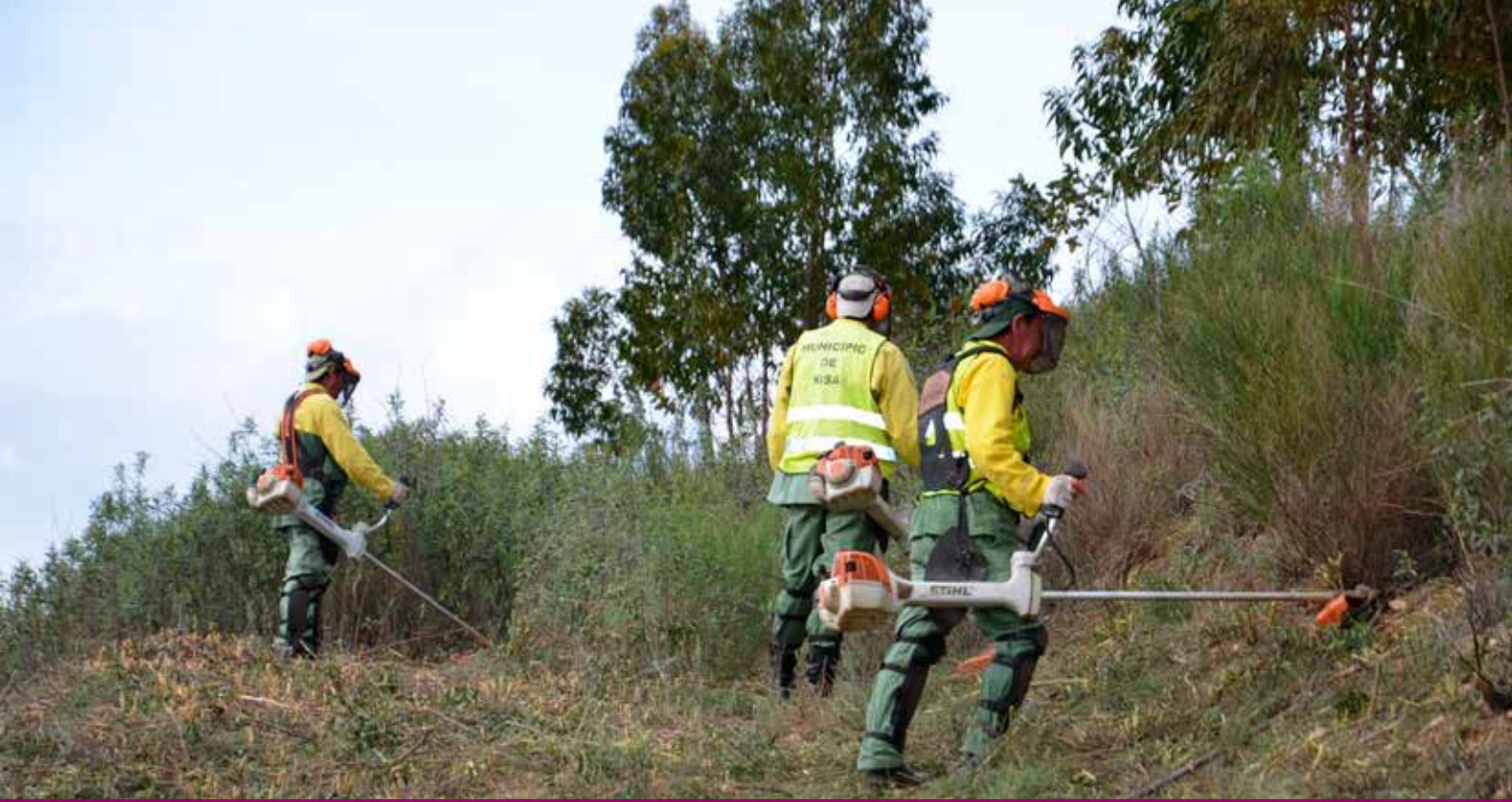
Manutenção das Redes Secundárias de Faixas de Gestão de Combustível
