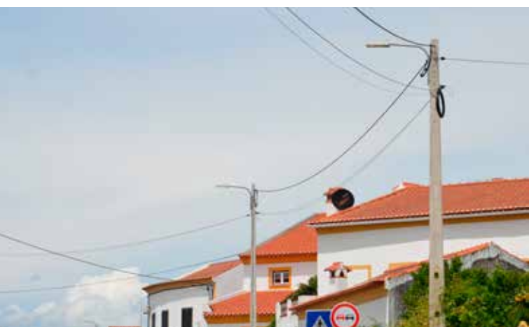
ALPALHÃO - Substituição total da iluminação pública por "leds"
