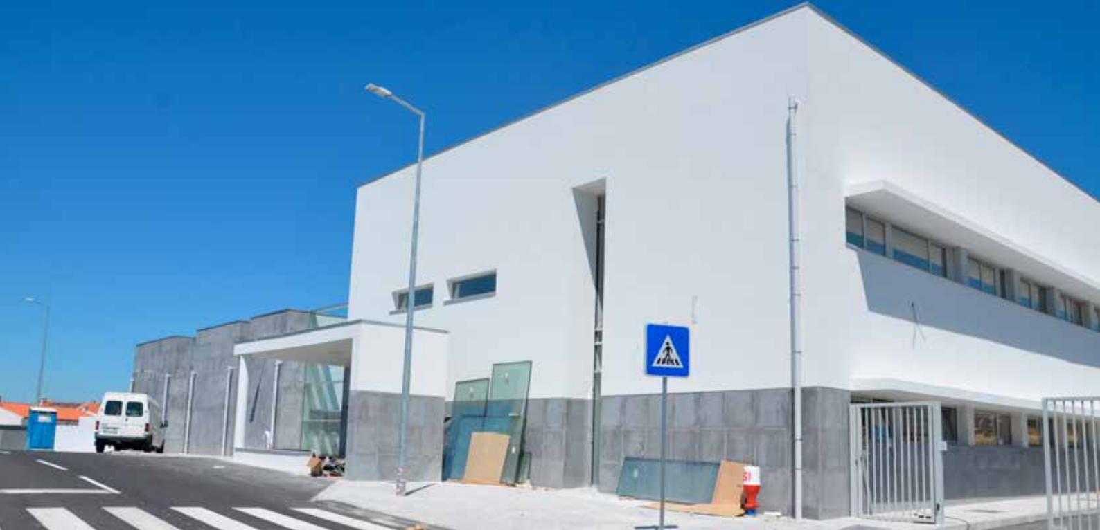
NISA Construção do novo Centro de Saúde de Nisa
