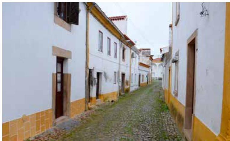
ALPALHÃO Requalificação da Rua Direita
