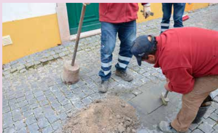
ALPALHÃO Reparação de lajetas
