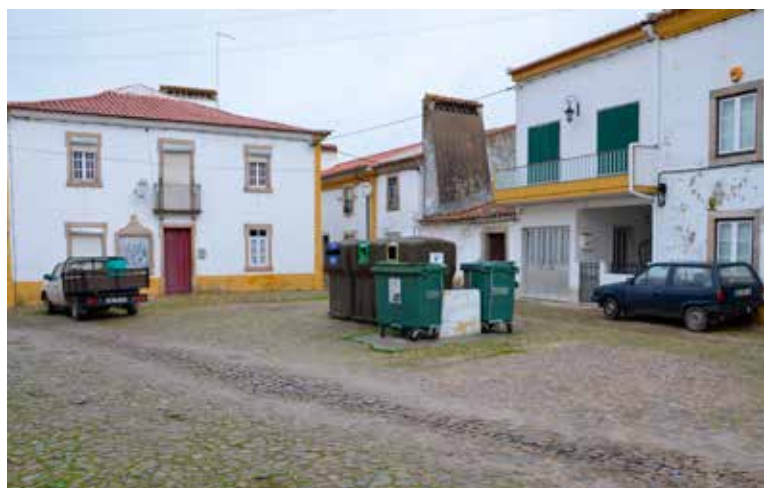
ALPALHÃO Requalificação do Largo do Terreiro
