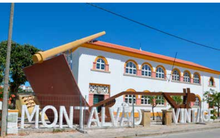
MONTALVÃO - Montalvão "Vintage" Valorização e Recuperação da Escola Primária
