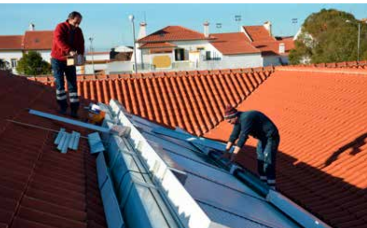
NISA Reparação de estores das janelas no Mercado
