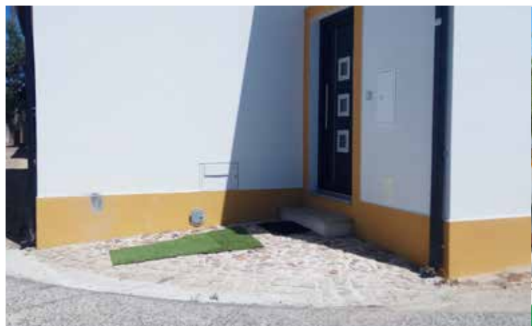
CACHEIRO Reposição de calçada
