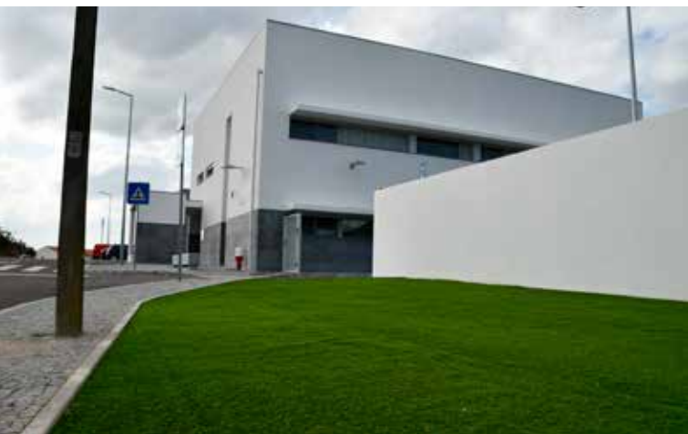
NISA Colocação de relva artificial no Centro de Saúde
