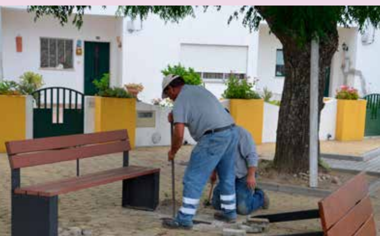
NISA Colocação de mobiliário urbano na Cevadeira
