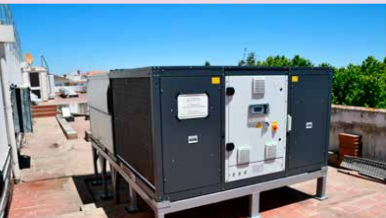
NISA - Substituição do equipamento de climatização no Cine-Teatro
