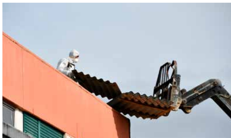
Remoção de amianto no Centro Escolar
