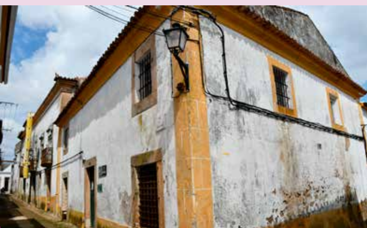
NISA - Centro Histórico Reabilitação do Edifício da Cadeia Velha
