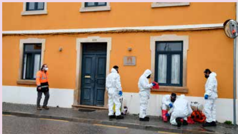
Solar Fonte da Pipa
