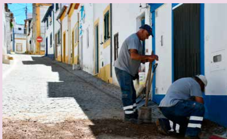
MONTALVÃO Reposição de calçada
