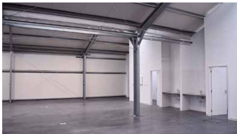
Espaço Interior - Hangar
