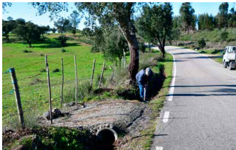
AREZ E AMIEIRA DO TEJO Limpeza de bermas e sumidouros
