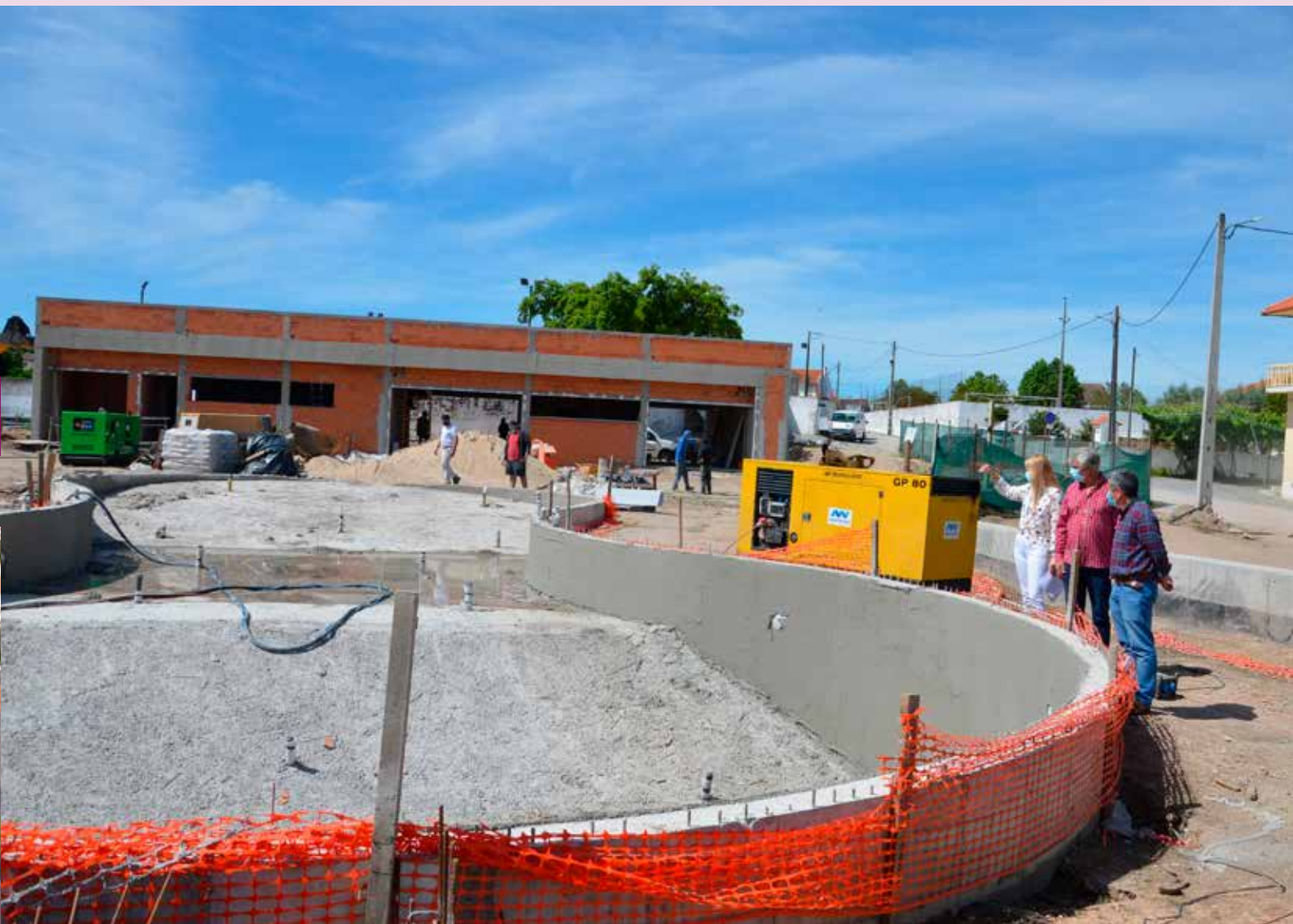
TOLOSA Construção de Piscina ao Ar Livre
