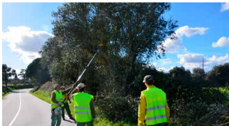
Limpeza de árvores na EM Nisa-Montalvão
