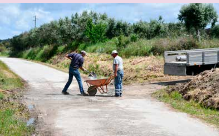
NISA - Reparação de pavimento na Estrada do Tarabau
