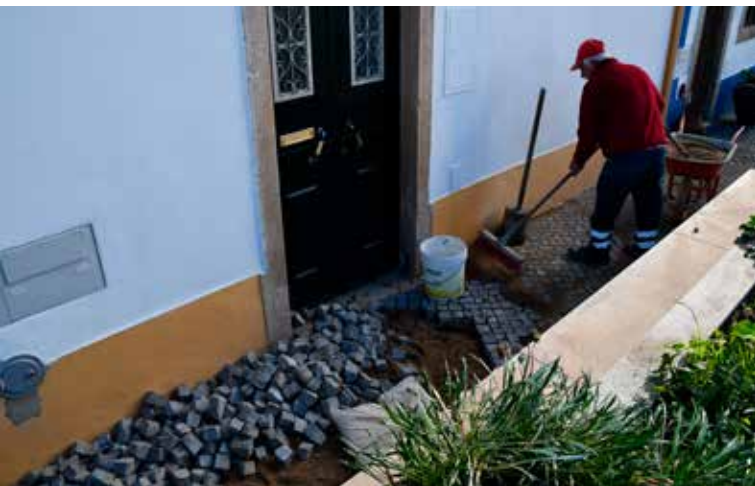
ALPALHÃO Reposição de Calçada
