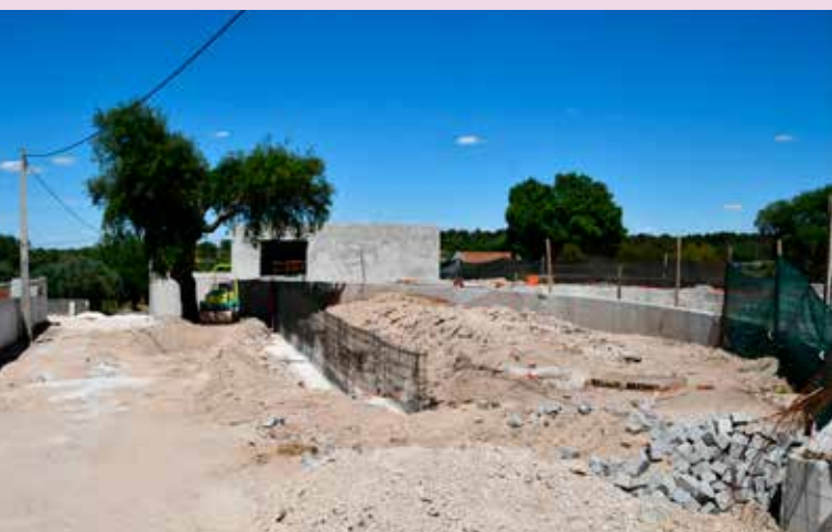
TOLOSA - Requalificação de ruas Rua da Praça de Toiros
