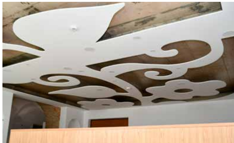
NISA - Requalificação do edifício do Hospital Velho - Interior
