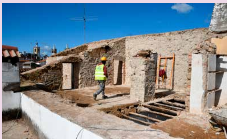
NISA - Centro Histórico Reabilitação do Edifício da Cadeia Velha
