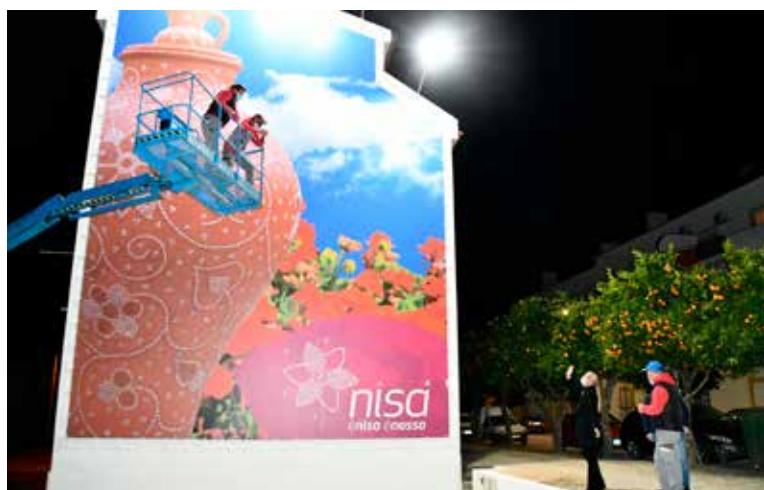
NISA Lona decorativa em prédio na Av. D. Dinis
