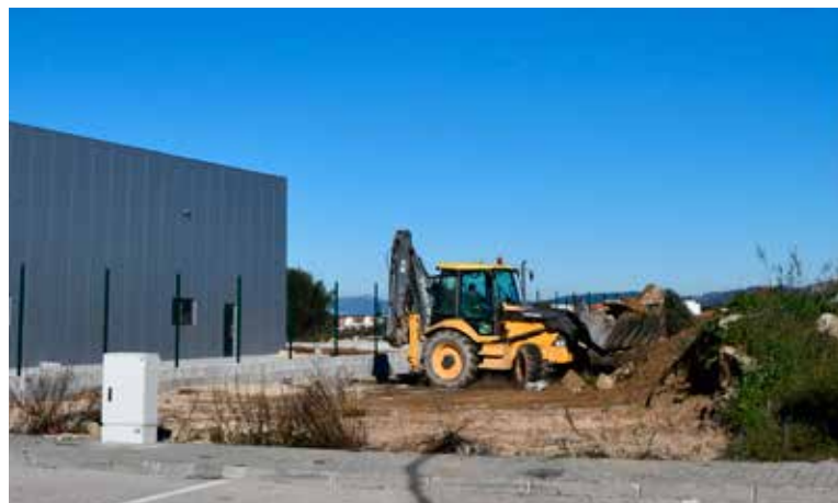
Trabalhos de terraplanagem na ZAE
