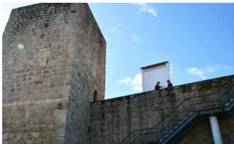
NISA Pinturas na Torre das Portas de Montalvão
