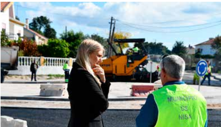
TOLOSA Construção da Rotunda de Tolosa
