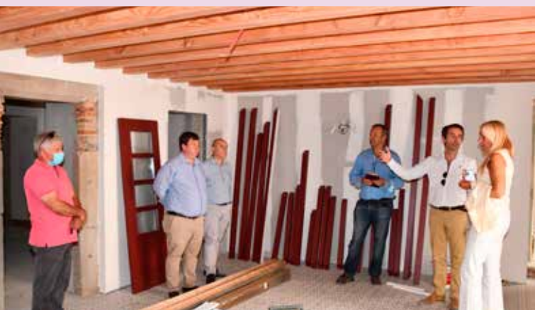
NISA - Requalificação do edifício adjacente à Cadeia Velha
