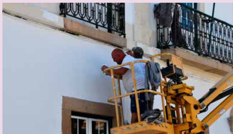
Apoio na beneficiação da Casa Lopes Tavares da SCM de Nisa
