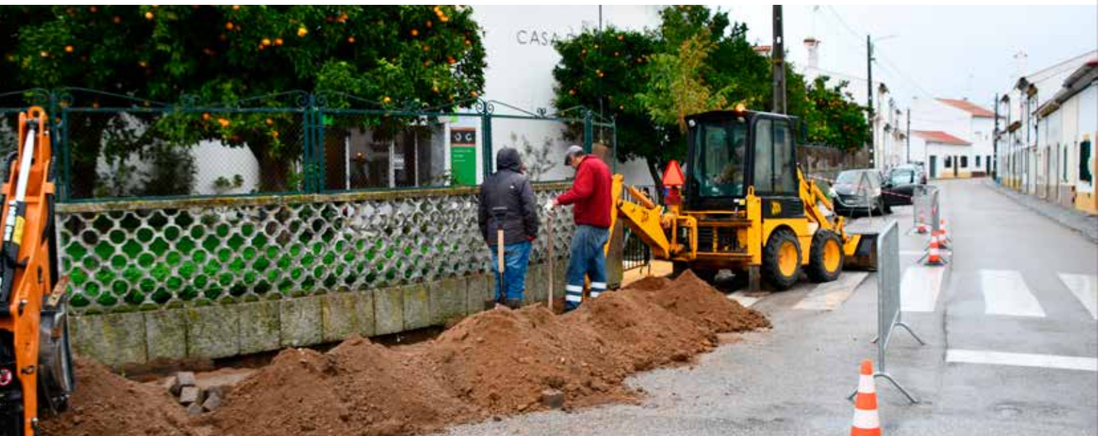
NISA Abertura de valas para instalação elétrica
