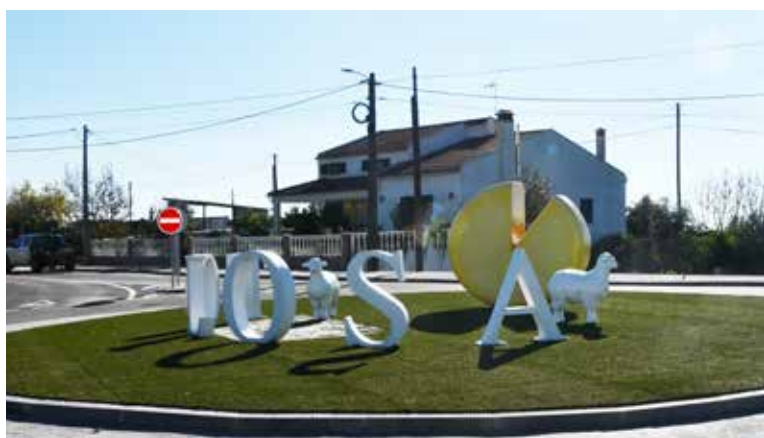
TOLOSA Construção da Rotunda de Tolosa
