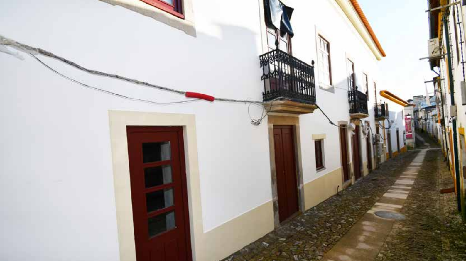
NISA Requalificação do edifício adjacente à Cadeia Velha
