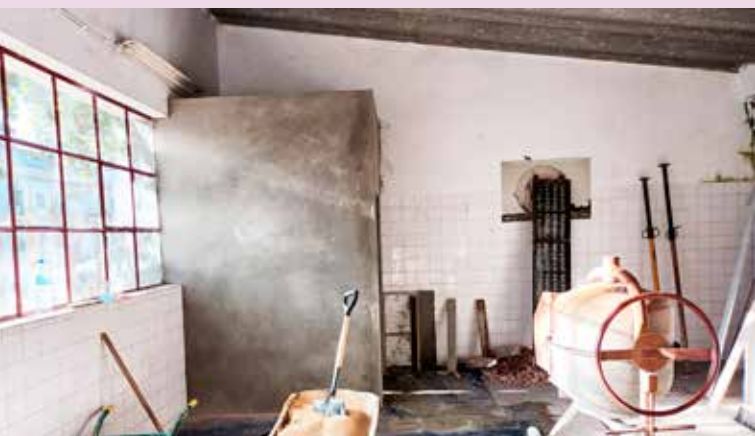
ALPALHÃO - Adaptação do Mercado Municipal para instalação de multibanco
