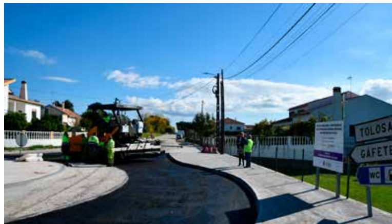
TOLOSA Construção da Rotunda de Tolosa
