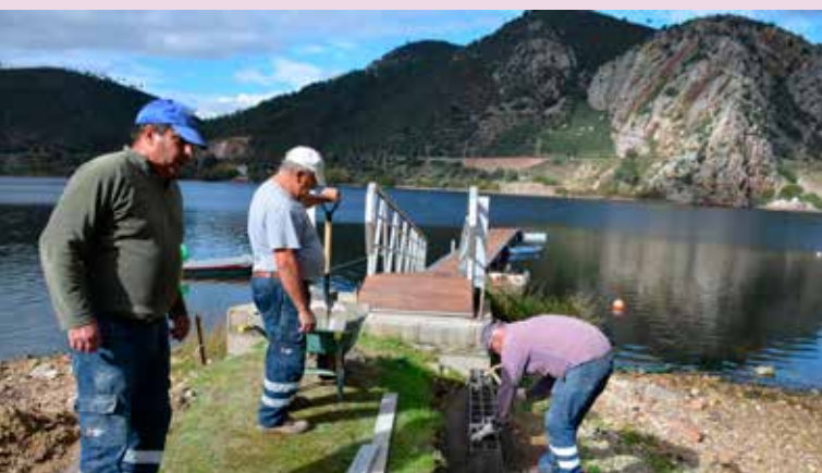
SANTANA Criação de rampa no cais do Pego das Portas
