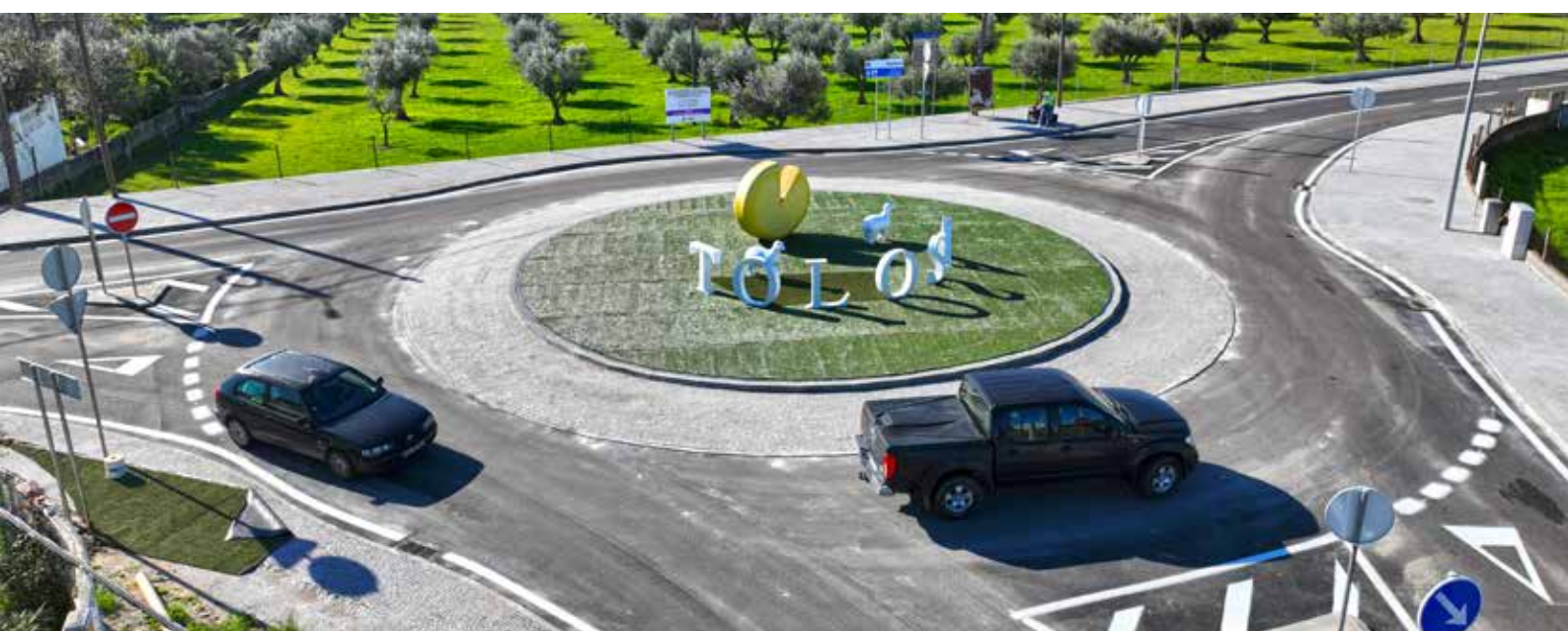
TOLOSA Construção da Rotunda de Tolosa
