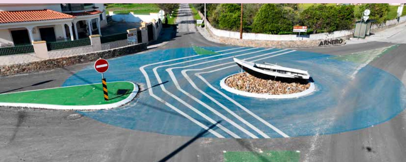
SANTANA Requalificação da Entrada do Monte do Arneiro
