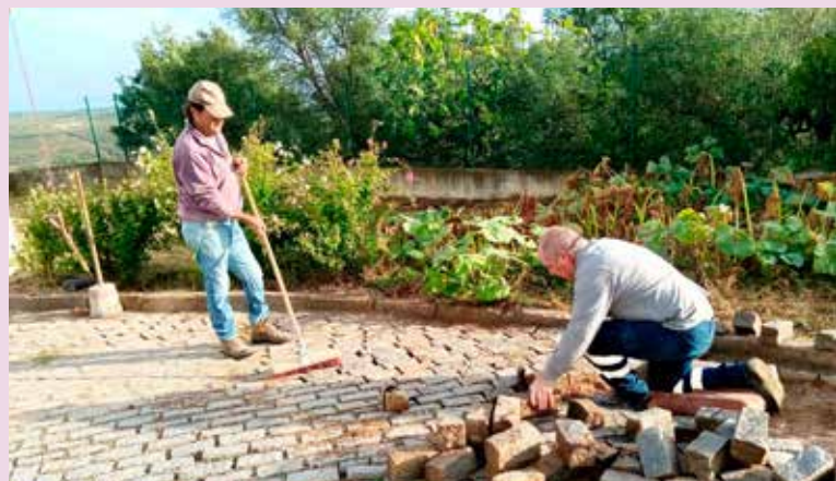
Reparações no Lar da Santa Casa da Misericórdia de Montalvão
