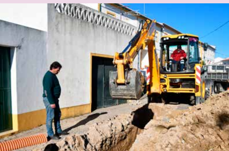
NISA - Remodelação do saneamento na Rua de S. Tiago
