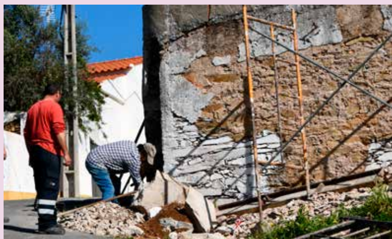
MONTALVÃO - Recuperação do muro de suporte do Largo de São Pedro
