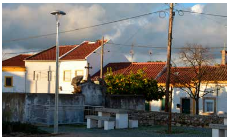
NISA Reforço das luminárias públicas
