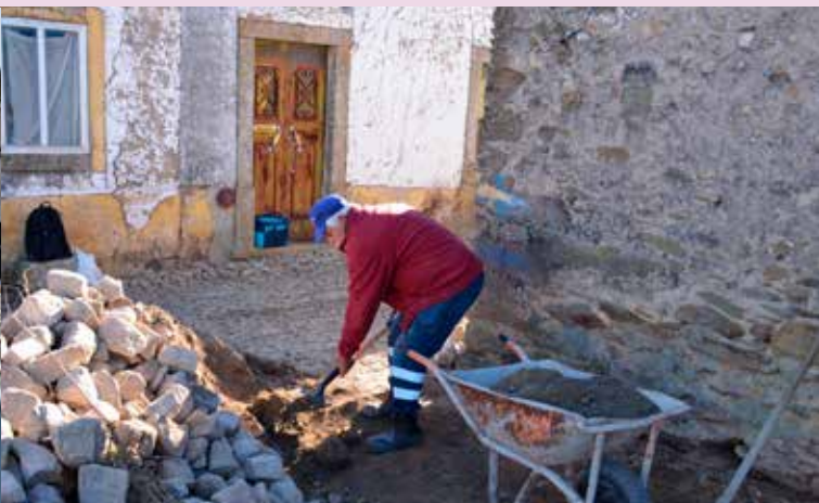
CACHEIRO Reposição de calçada
