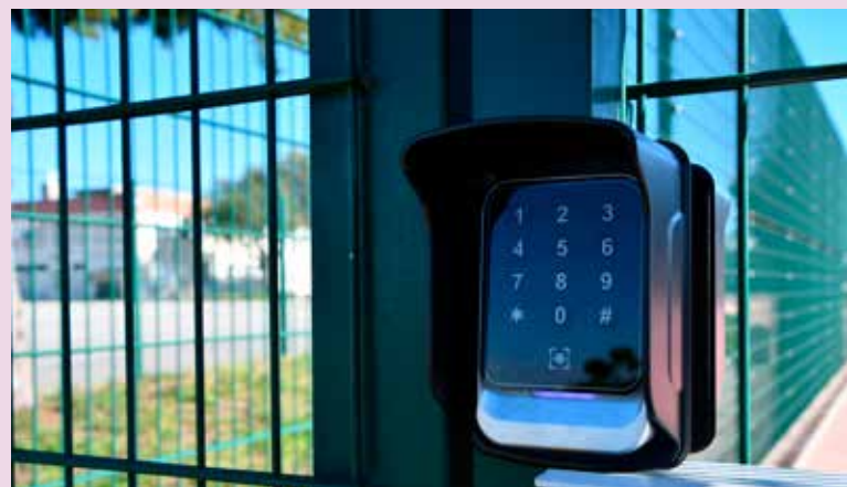
Instalação de sistema de acesso ao Campo de Ténis
