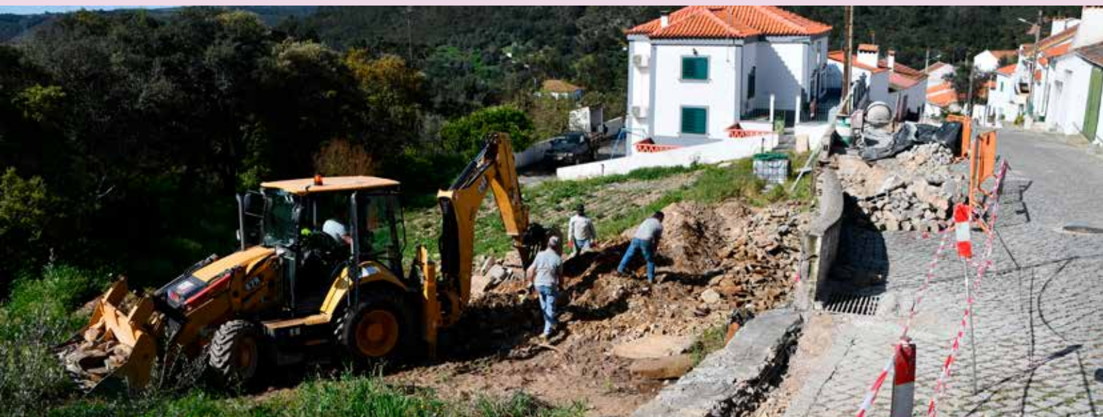
PÉ DA SERRA Recuperação de muro meeiro
