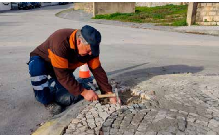
NISA Reposição de calçada
