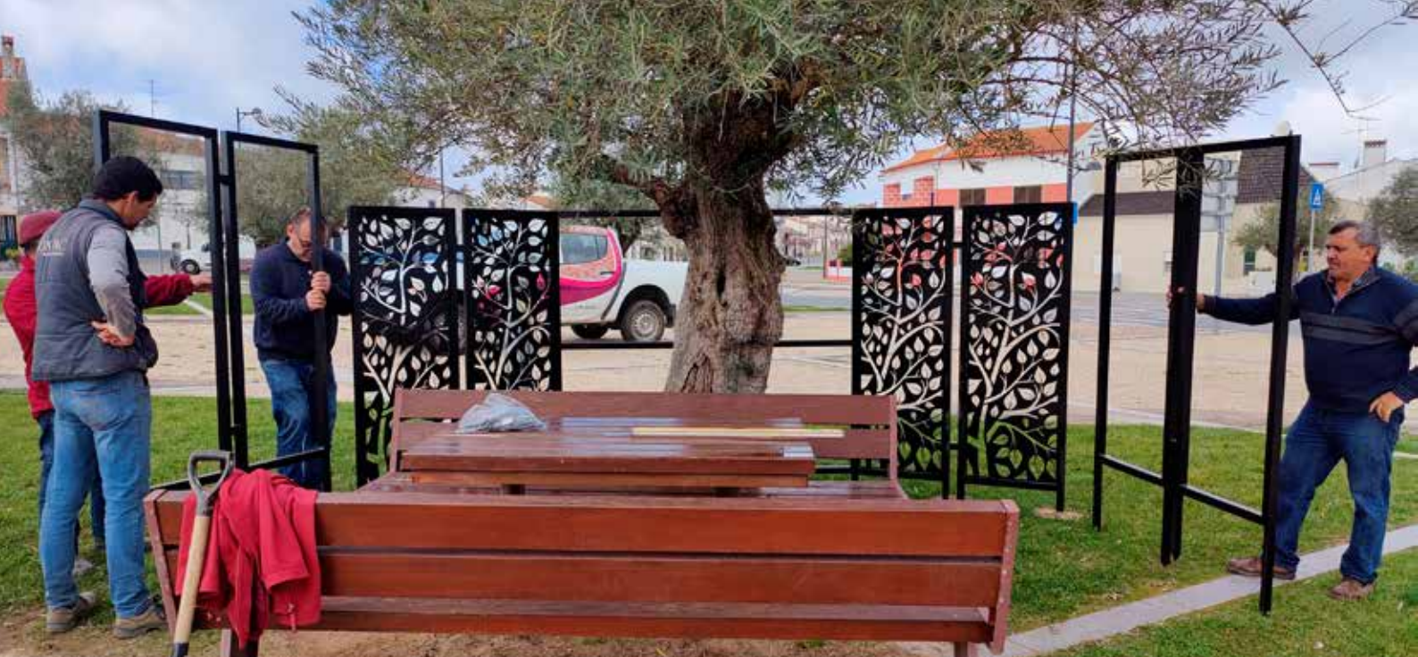
NISA Instalação de sombreamento na Devesa
