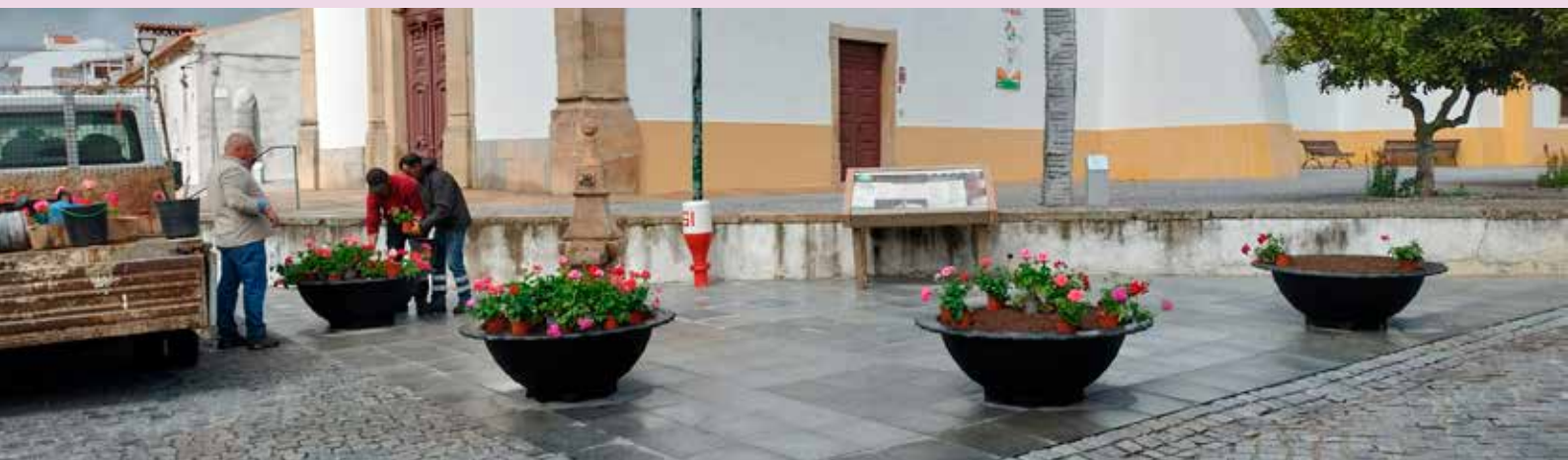
ALPALHÃO Instalação de floreiras no Largo do Adro
