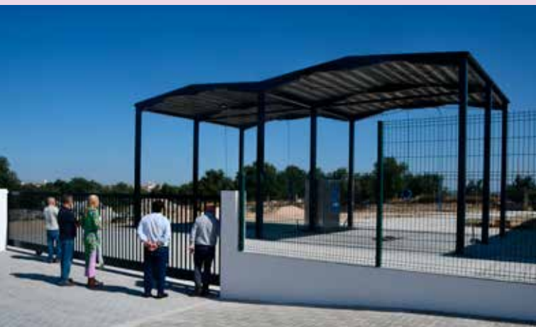
NISA - Execução de Centro de lavagem para viaturas municipais
