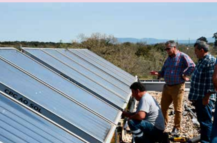
NISA - Substituição de canalização do sistema solar no Complexo Termal
