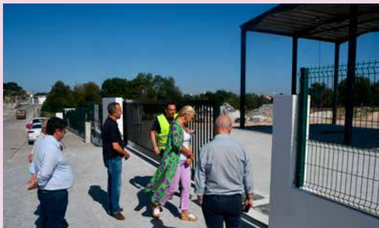
NISA - Execução de Centro de lavagem para viaturas municipais - Valor: 137.000,00 € + IVA
