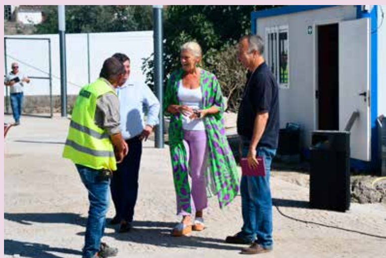
NISA Construção de dois campos de padel
