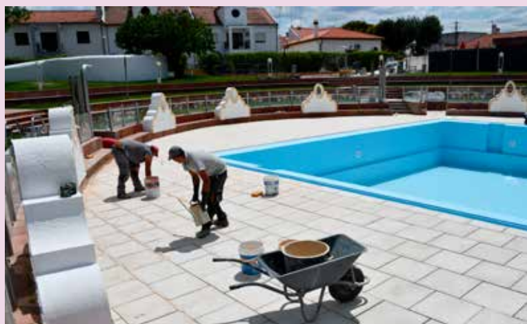
NISA Substituição do piso envolvente à piscina
