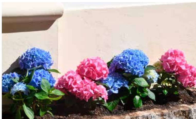
NISA - Construção de floreiras junto à Cadeia Velha
