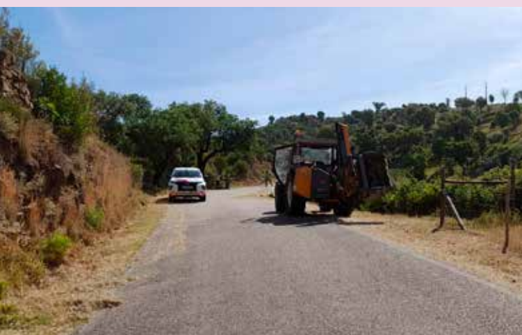
Limpeza de bermas de estrada em Amieira do Tejo
