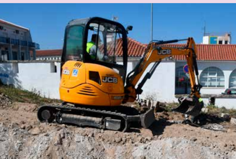
NISA Construção de dois campos de padel
