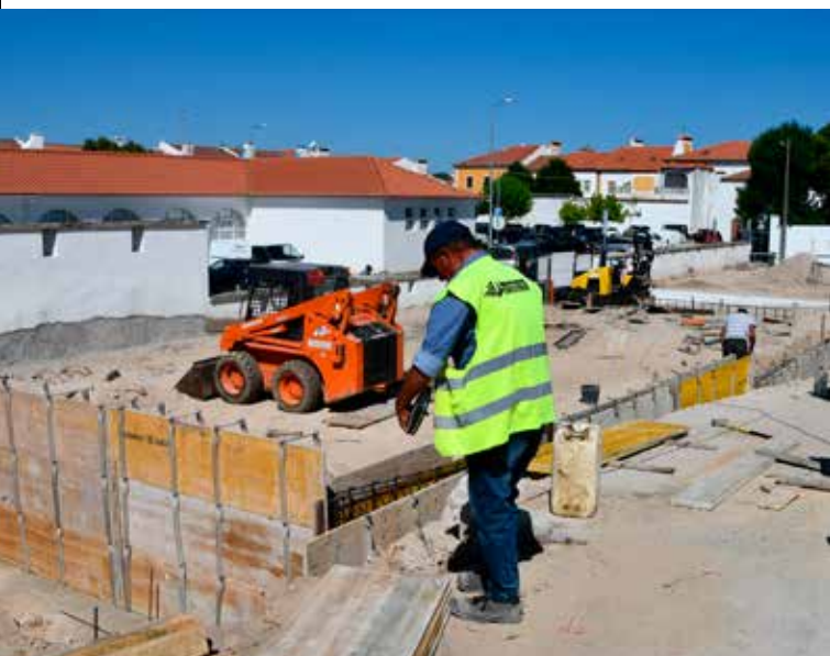
NISA - Construção de dois campos de padel - 146.422,70 € + IVA
