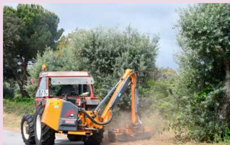
Limpeza de bermas de estrada em Montalvão
