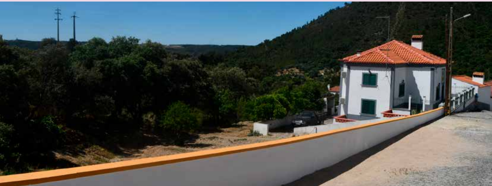
PÉ DA SERRA Reabilitação de muro de contenção em pedra seca na Rua das Carretas - Valor: 17.368,00 € + IVA
