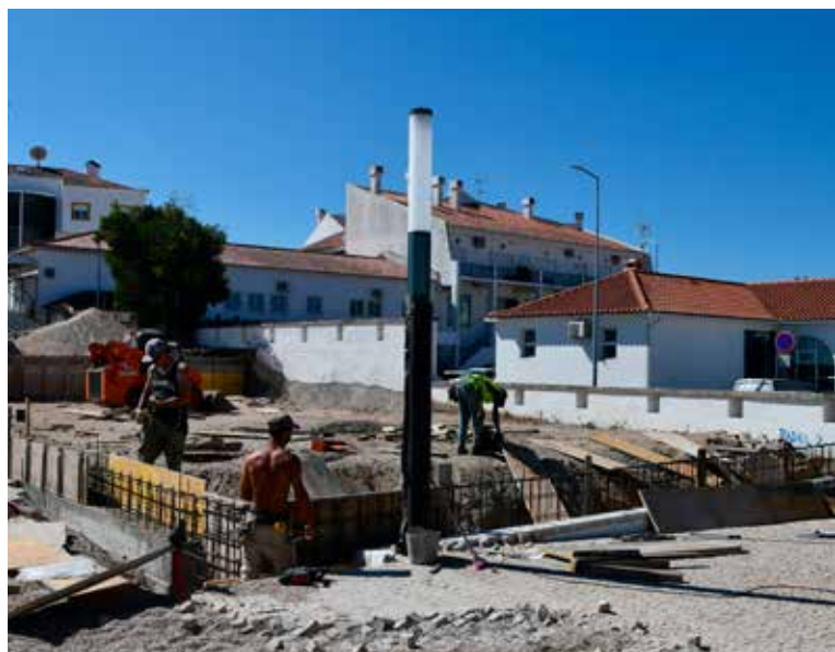
NISA Construção de dois campos de padel
