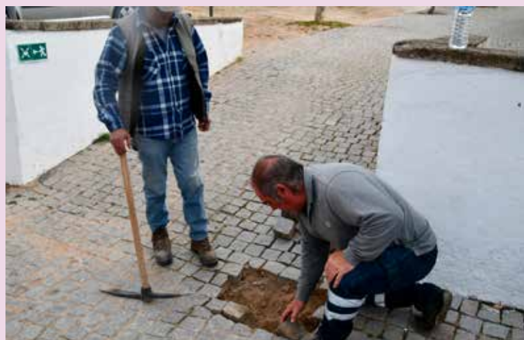
MONTALVÃO Reposição de calçada
