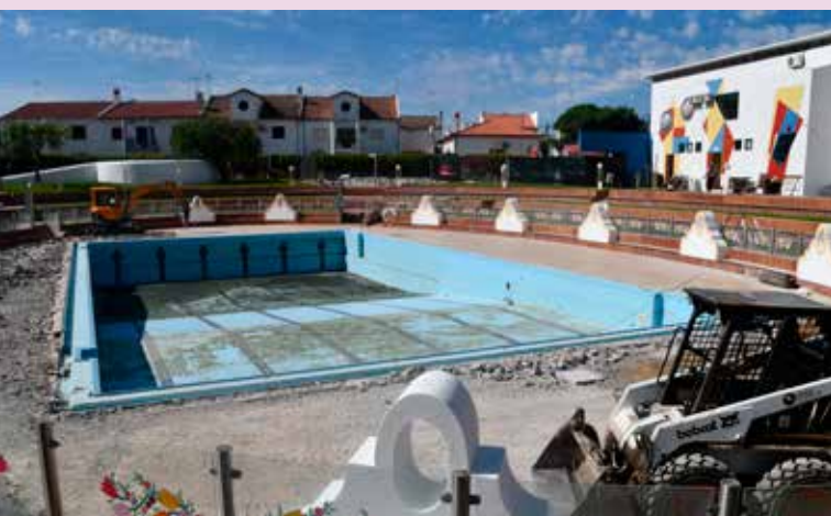
NISA Substituição do revestimento da piscina
