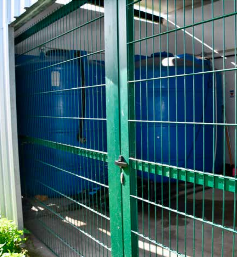
Instalámos um novo reservatório de água no Cacheiro.
