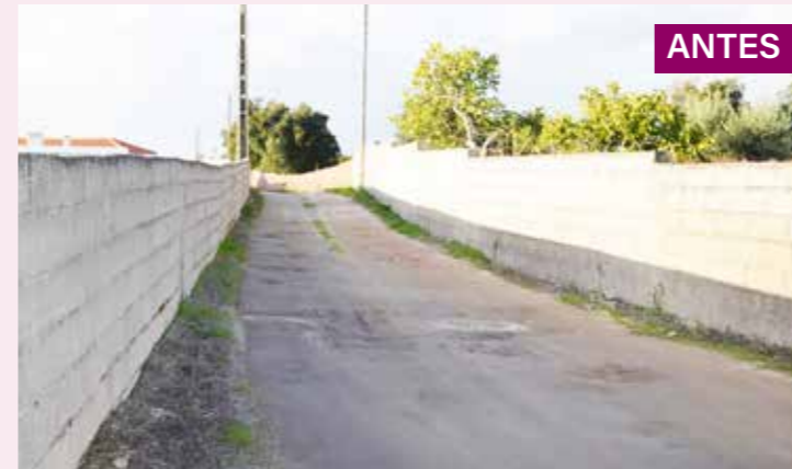
Beneficiação da Rua das Safras em Alpalhão
