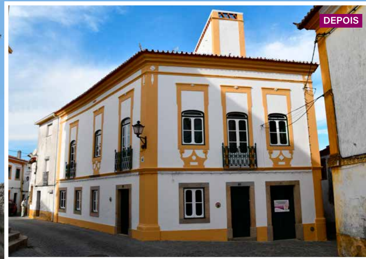
Criámos o programa "Vamos, juntos, dar um novo Brilho à Vila!" que já recuperou muitas fachadas do Centro Histórico.
