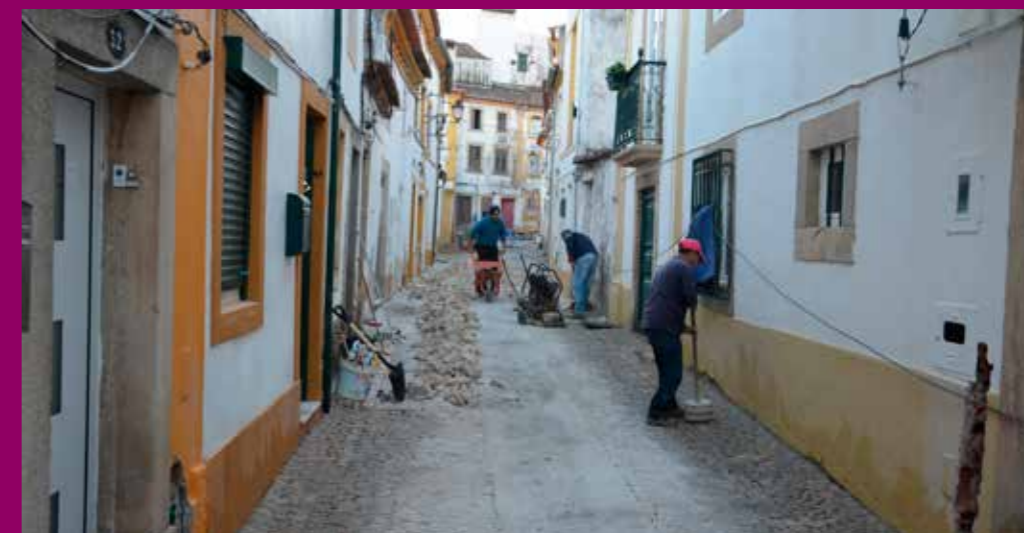
Requalificámos todas as ruas do Centro Histórico de Nisa dotando-as de passadeiras centrais e de novas redes de canalizações
