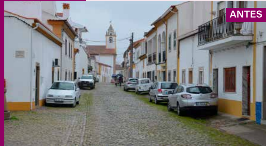
Requalificação da Rua de Santo António em Alpalhão
