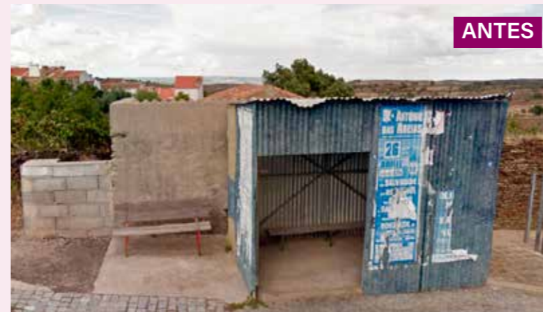
Substituição da paragem do abrigo de passageiros em Salavessa
