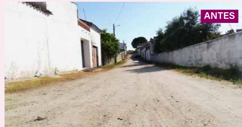
Pavimentação da Rua Nº 3 em Alpalhão
