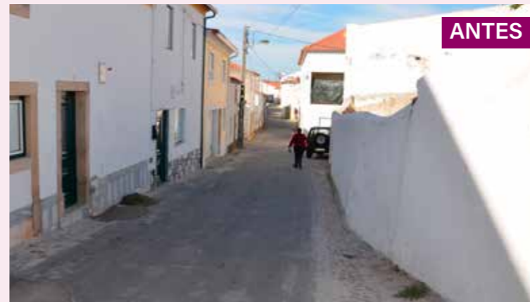
Requalificação da Rua da Cooperativa em Tolosa
